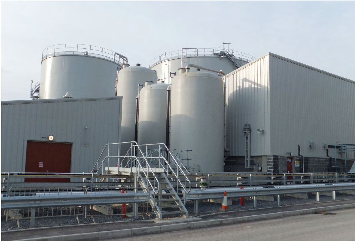
Установка деионизации HAGER + ELSÄSSER на электростанции в Пембруке/Южный Уэльс.
