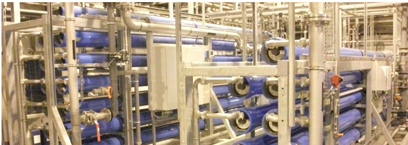
Основная система обратного осмоса (ступень 1) и дополнительная установка обратного осмоса (ступень 2).
