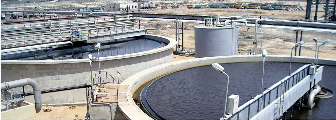
Sedimentationsstufen der anaeroben und aeroben Reinigung.
